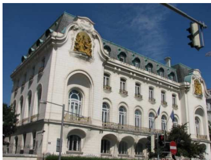
Façade sur la Schwarzenbergplatz
